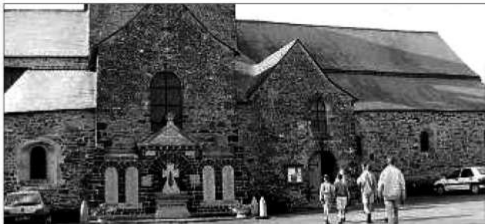
L'église Saint-Pierre- Saint-Paul à la veille d'une restauration.
