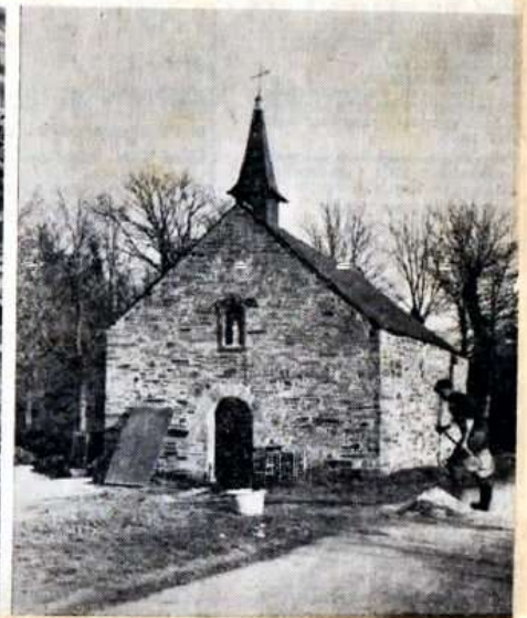
La chapelle Saint-Joseph, vue extérieure.
